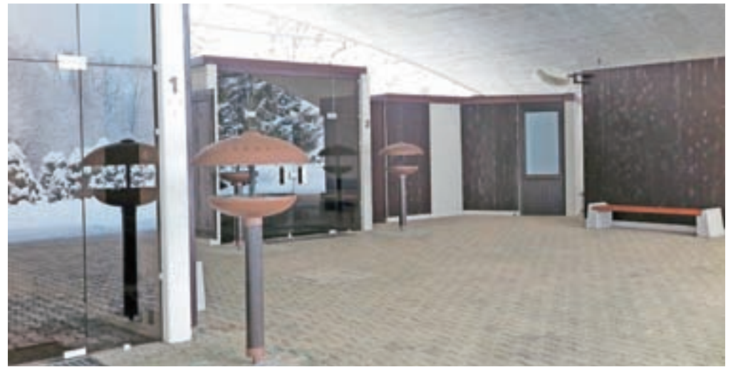
Še to pomlad se bo začela obnova dotrajanih poslovilnih vežic na radovljiškem pokopališču.
