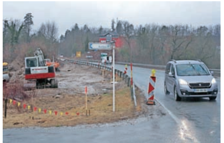
Začela so se dela na betinskem klancu.
