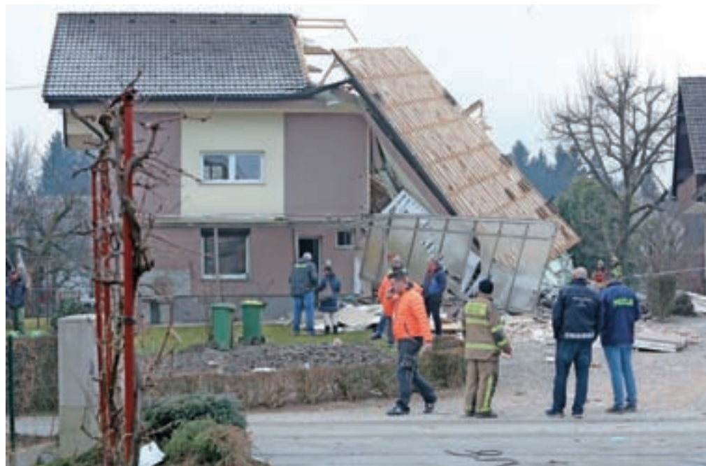
Ob eksploziji plina se je porušila skoraj polovica stanovanjske hiše. / Foto: Gorazd Kavčič
