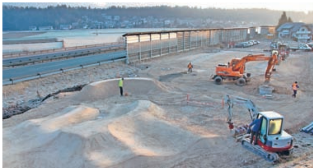
Mladinsko športno igrišče je umeščeno od avtoceste proti novemu krožišču v Naklem, njegovo končno podobo na občinski upravi pričakujejo marca.
