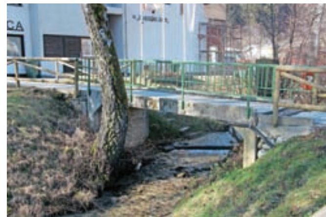
Na tej lokaciji so trije mostički. Po dograditvi gasilskega doma v Bistrici pri Trziču, ki že poteka, Občina Trzič načrtuje tudi sanacije površin v soseščini.
