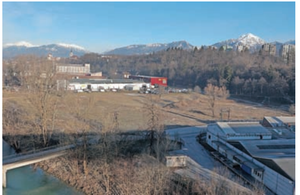
Sosese Ob Savi bo Stanovanjski sklad z lastnimi sredstvi zgradil na območju nekdanjega barakarskega naselja Koreja v Kranju. / Foto: Tina Dokl
