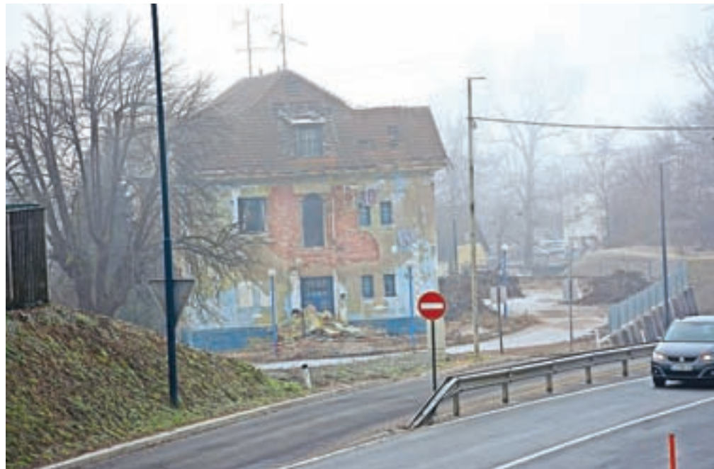
Propadajoči Sokolski dom, stavba, ki je bila nekdanj ponos Medvod, je predviden za rušitev.
