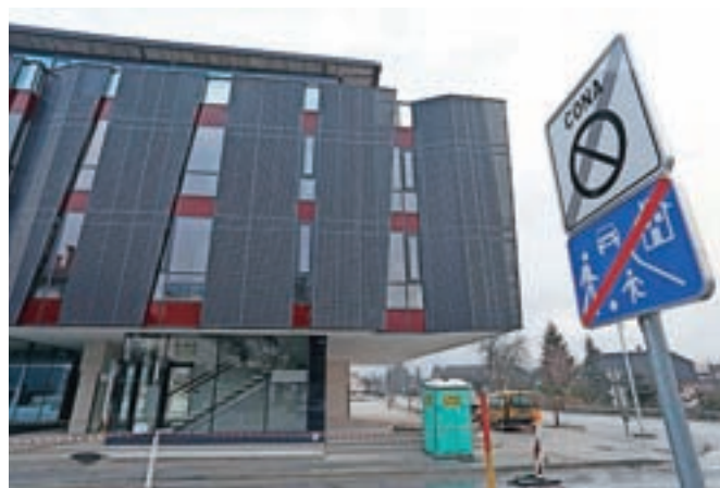
Glavna dela na stavbi nove knjižnice v Radovljici so zaključena, a treba bo kupiti še parkirna mesta v garažni hiši.
