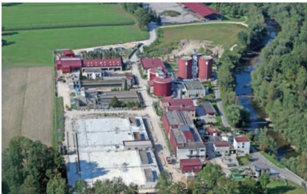
Nadgradnja CCN Domžale - Kamnik pomembno vpliva na izboljšanje kakovosti reke Kamniška Bistrica, varovanje podtalnice in zagotavljanje čiste pitne vode, a varovanje okolja tudi stane.
