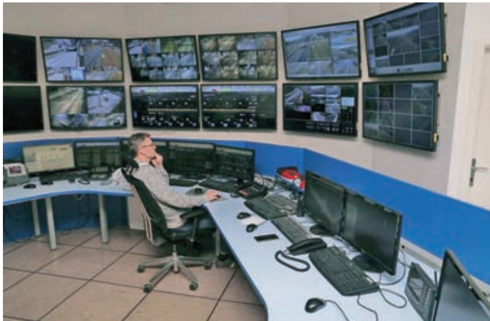
Operaterji pravijo, da je predor Karavanke (pokriva ga več kot dvajset kamer in nadzorni sistem) po prenovi ventilacije in nadzornih sistemov bistveno varnejši.
