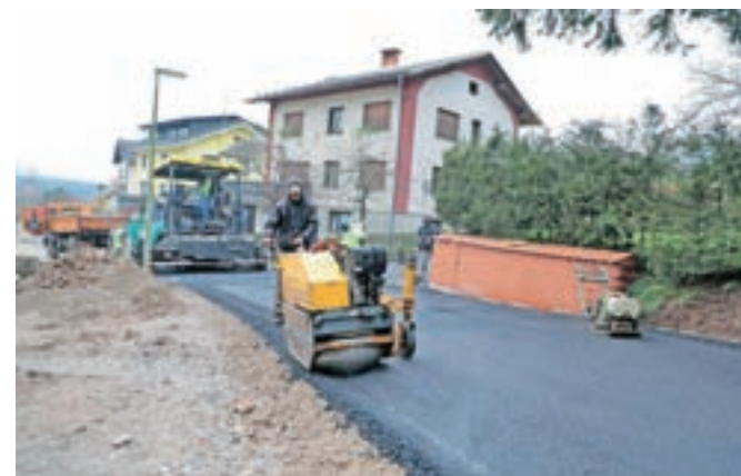
Z asfaltiranjem ceste proti Možjanci so končali drugo fazo gradnje kanalizacije v Tupaličah. / Foto: Tina Dokl
