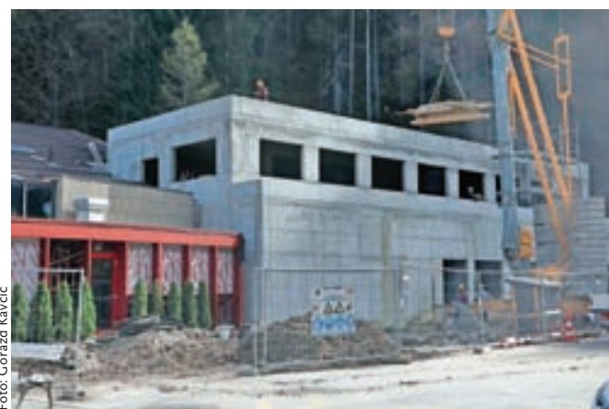
Prizidek k igralnici bo predvidoma zgrajen do konca leta, celotna prenova pa zaključena do avgusta prihodnje leto.
