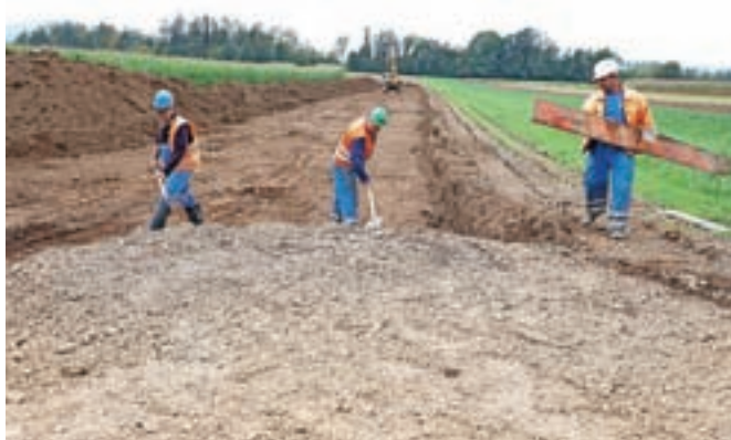
Gradijo cesto proti čistilni napravi v Trbojah. / Foto: Tina Dokl
