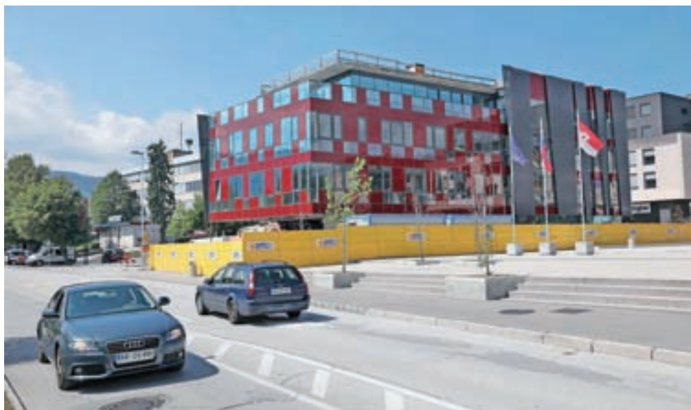
Nova radovljiška knjižnica naj bi bila, potem ko so bile odpravljene težave pri tesnjenju strehe, po zadnjih načrtih zgrajena do sredine decembra. / Foto: Gorazd Kavčič
