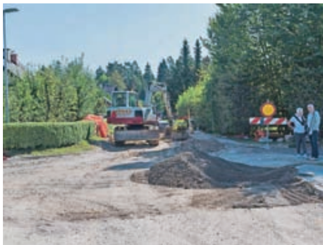
V Sajovčevem naselju za letos končujejo gradbena dela na kanalizacijskem sistemu. / Foto: Gorazd Kavčič
