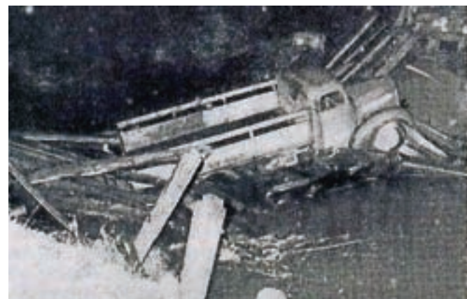
Pri Podhumu je most klonil pod težo tovornjaka s pivom, ki se je znašel v reki Radovni. / Foto: arhiv GG, 20. marec leta 1959
