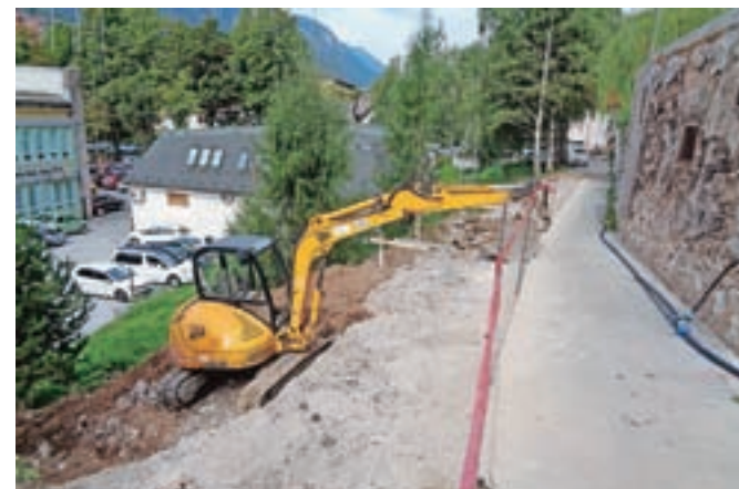
Murova je že razkopana, začeli so z gradnjo dveh novih opornih zidov.
