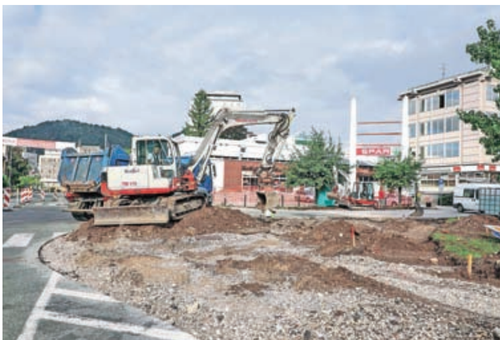
Dela za ureditev krožišča pri kranjskem sodišču so se že začela. /Foto: Tina Dokl
