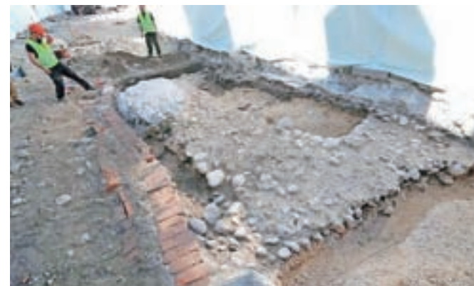
Ob gradbenih delih v središču Kamnika so našli ostanke nekdanjega mestnega obzidja.
