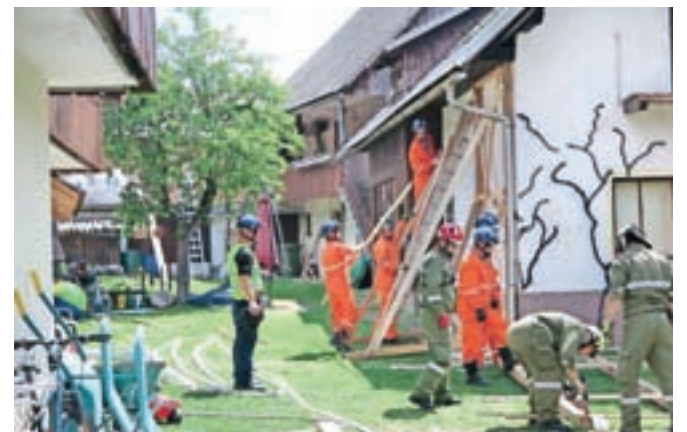
Ekipi za tehnično reševanje Gorenjske in avstrijske Koroške sta združili moči pri reševanju ponesrečencev iz porušenega objekta po potresu. / Foto: Simon Šubic
