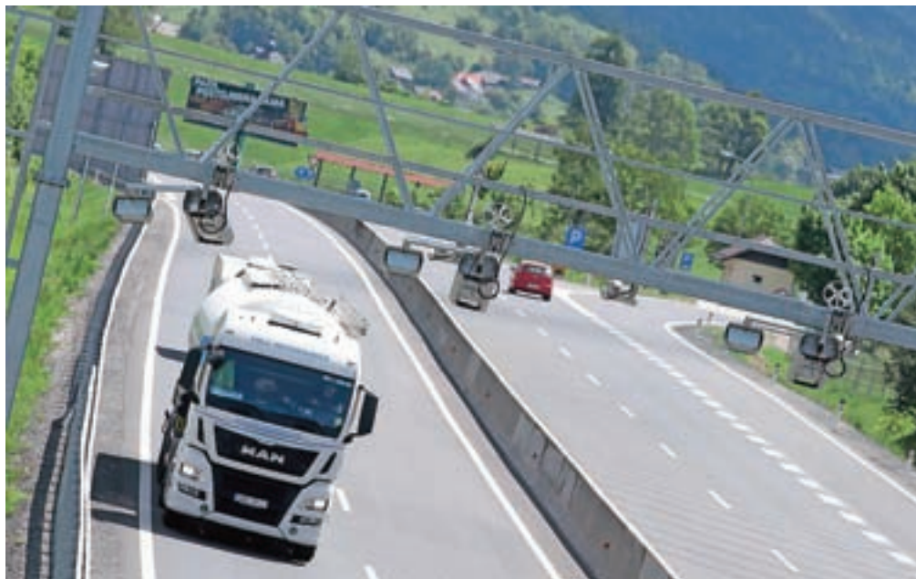
Portal za elektronsko cestninjenje težkih vozil pri Lipcah na gorenjski avtocesti je že postavljen. / Foto: Gorazd Kavčič
