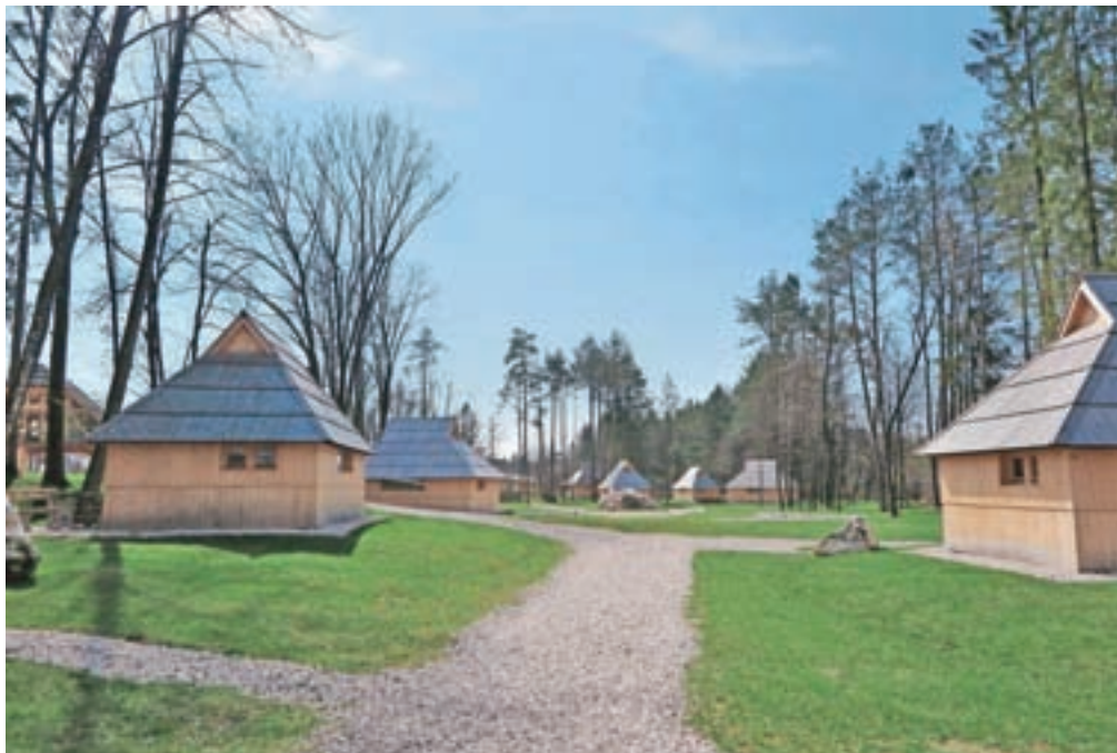
Gradbeni inšpektor je odločil, da bo sedemnajst lesenih hišk v Eko resortu pod Veliko planino treba porušiti, saj so črna gradnja.
