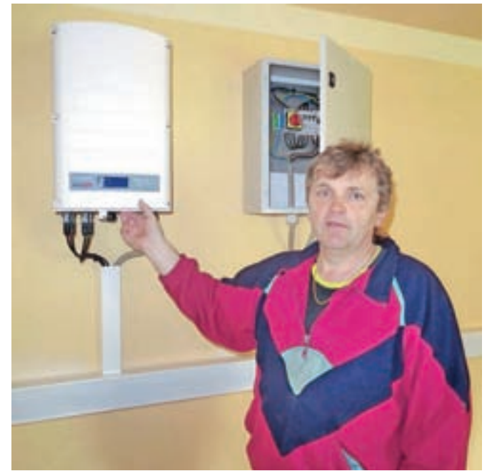
Pretvornik enosmerne napetosti v izmenično je srce elektrarne, pravi Božo Prezelj.
