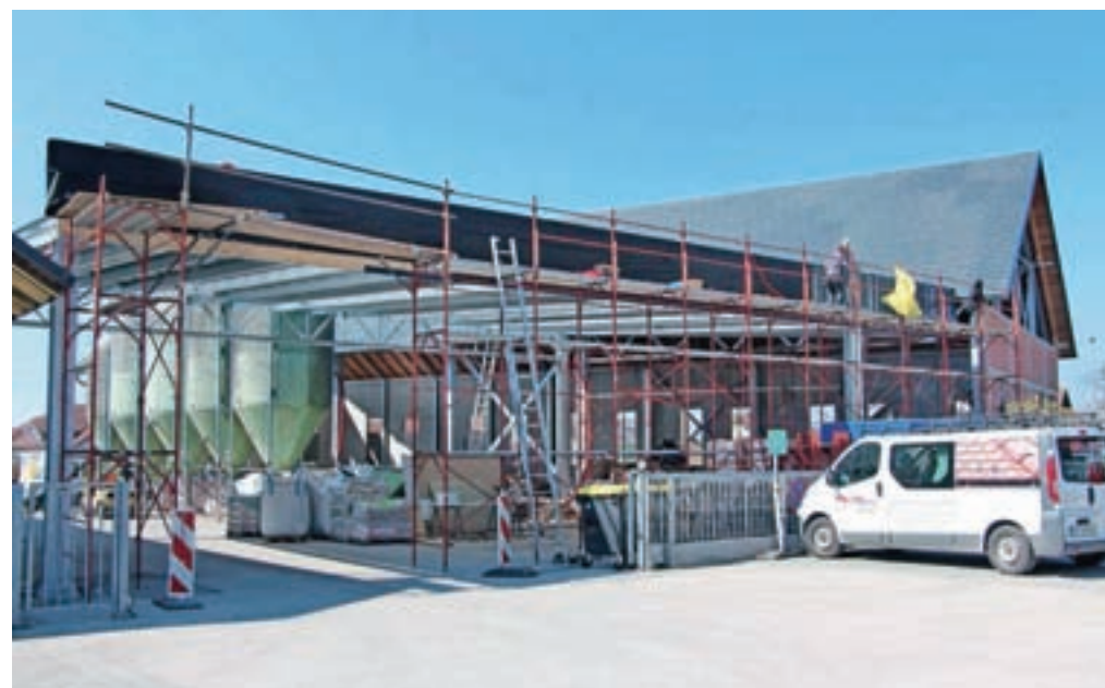
Zadruga gradi v Cerkljah novo stavbo, v kateri bosta skladišče gradbenega materiala in zbirni center za mleko.
