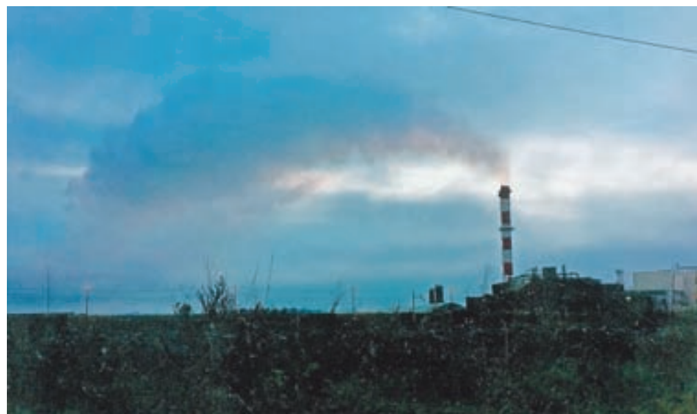
Dimni oblak iz Knaufovega dimnika, preden so bili izvedeni sanacijski ukrepi.
