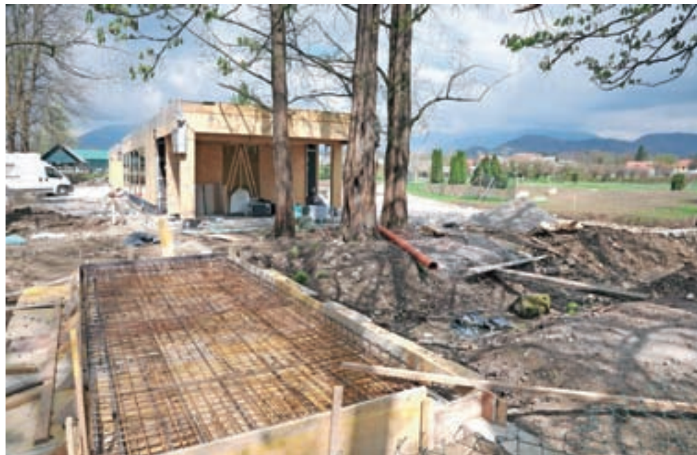
Še zadnja dela pri gradnji novega vstopnega objekta / Foto: Gorazd Kavčič
