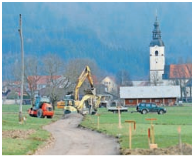
Gradnja pločnika Preddvor–Breg / Foto: Tina Dokl
