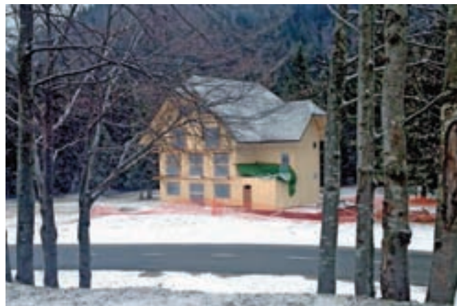
Na Soriški planini so pred kratkim začeli graditi hotel, ki ga nameravajo dokončati do naslednje zime. / Foto: Gorazd Kavčič
