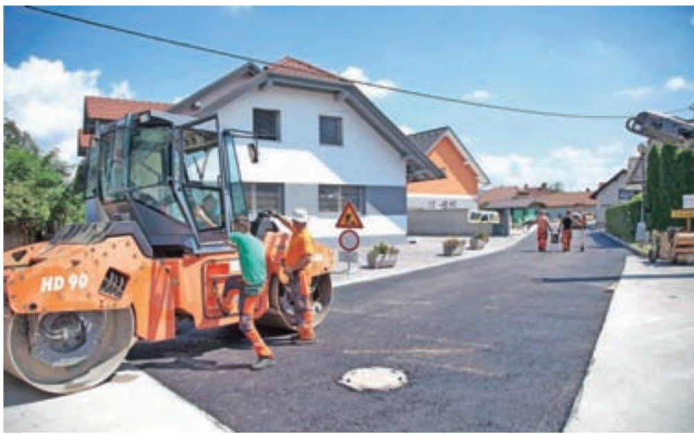
Na nekaterih delih v Mostah že poteka asfaltiranje. Dela bodo v tem naselju v celoti zaključena novembra. / Foto: Aleš Senožetnik
