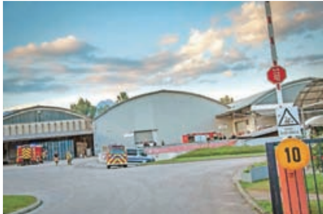
Že v četrtek pod večer je zaradi odvrgnenih cigaretnih ogorkov zagorelo v prežračevalnem jašku skladiščno-poslovnega objekta na Cesti na Okroglo v Naklem. / Foto: Luka Renar
