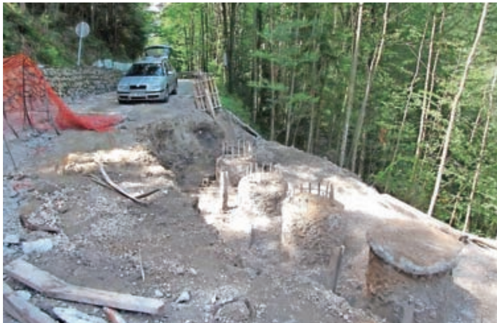
Dela pri sanaciji zemeljskega plazu in gradnji ceste so zelo zahtevna.
