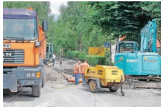
Del Ljubljanske ceste, kjer je bilo cestišče že povsem dotrajano, bo predvidoma že prihodnji teden prenovljen in znova odprt za promet. / Foto: Gorazd Kavčič
