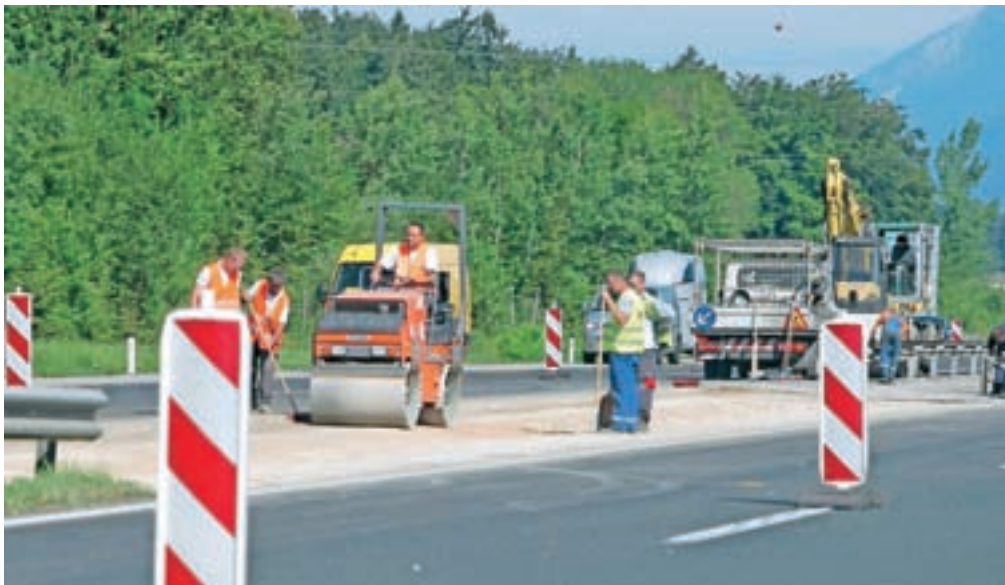
Ta teden so se na avtocesti začela pripravljala dela. / Foto: Gorazd Kavčič
