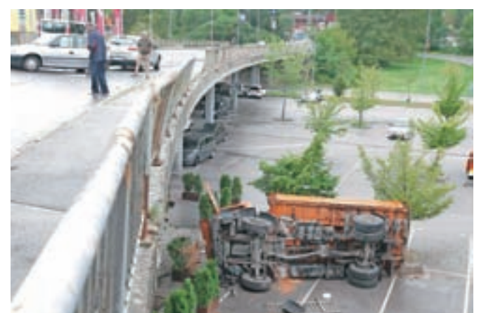
Ponedeljkova nesreča, ki se je k sreči končala brez hujše poškodovanih, je novo opozorilo, da je cesta na tem delu potrebna obnove. / Foto: Gorazd Kavčič
