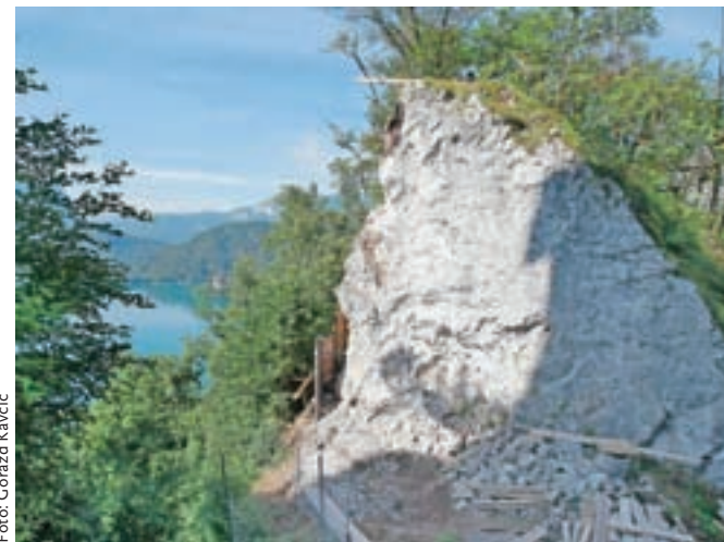
Poškodbe na skali so nastale kot posledica zime.
