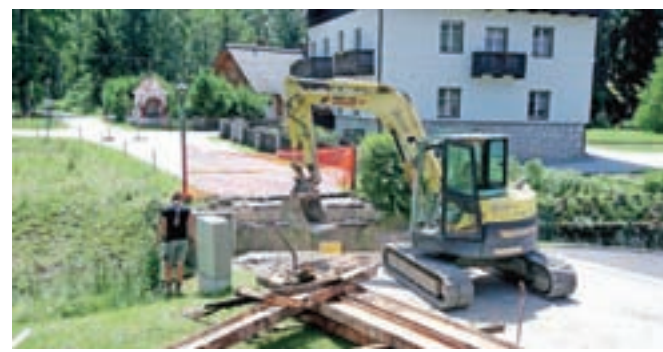
Gradijo nov most čez Jezernico pri Kazini. / Foto: Tina Dokl
