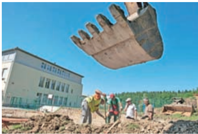
Gradnja obračališča pri Osnovni šoli Matije Valjavca Preddvor / Foto: Matevž Čebašek
