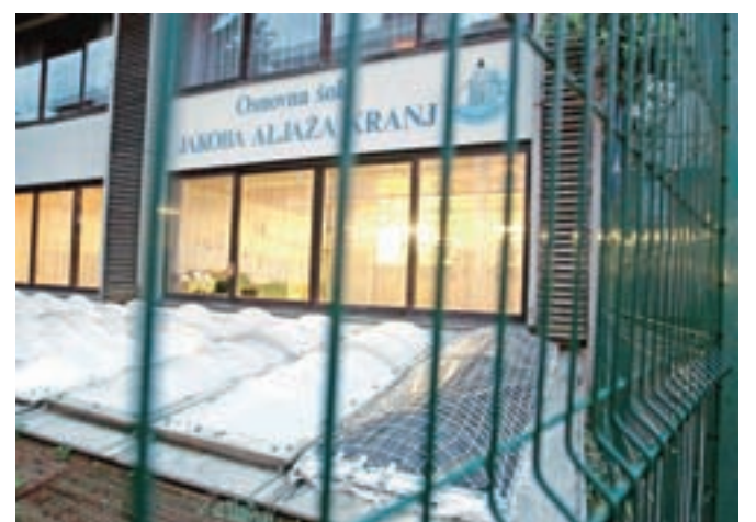
Počeno stekleno kupole so v sredo zvečer takoj po nesreči zakrili s platnom in dodatno zaščitili z mrežo. / Foto: Gorazd Kavčič
