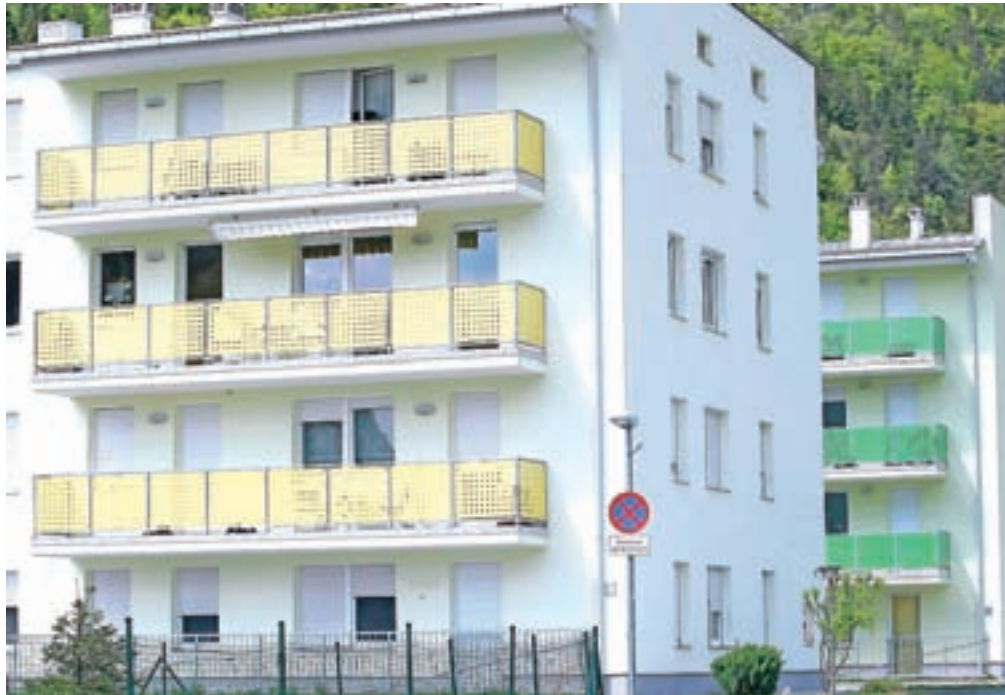
Stavba, v kateri so tudi neprofitna stanovanja, na Jesenicah. / Foto: Gorazd Kavčič
