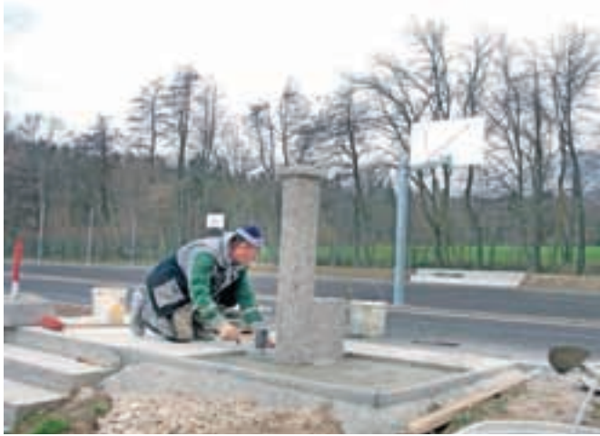
Zadnja dela pri urejanju šolskih športnih površin v Preddvoru / Foto: Tina Dokl
