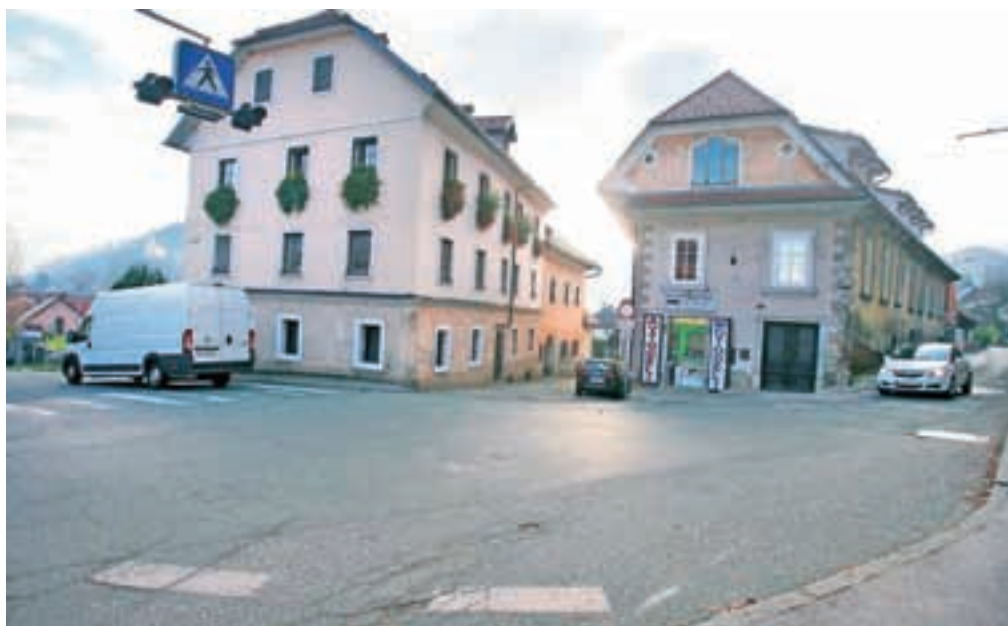
Promet na cesti od starega Petrola do krožišča v Zmincu se je v primerjavi s časom pred odprtjem obvoznice razpolovil, a ga je po mnenju prebivalcev še vedno preveč / Foto: Tina Dokl
