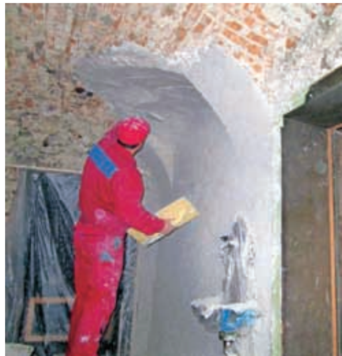
Cement nima v starih hišah kaj iskati, so odločno zatrdili mojstri v Kvandrovi hiši.
