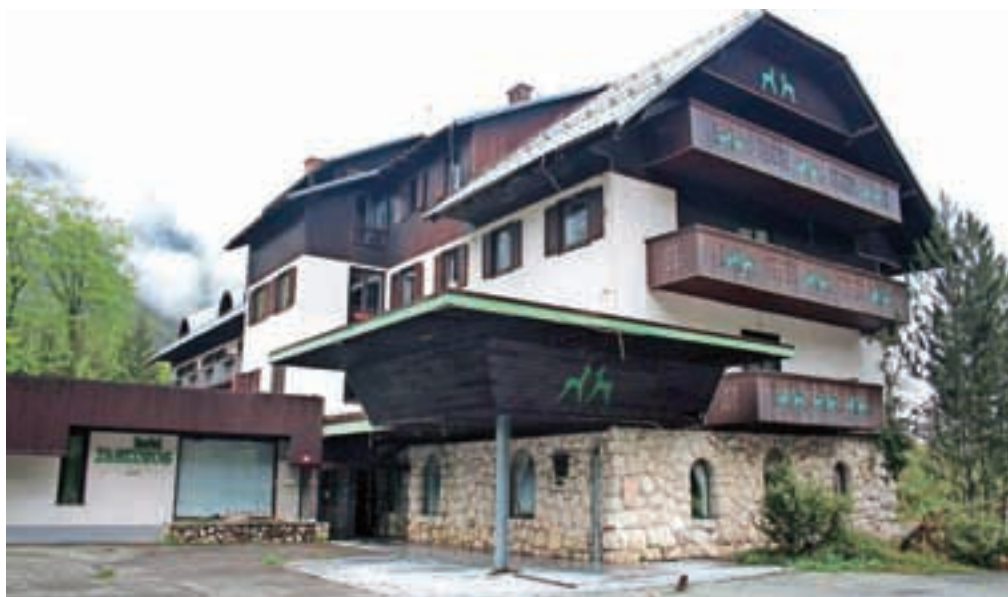
Propadajoči hotel Zlatorog, nekoč ponos bohinjskega turizma
