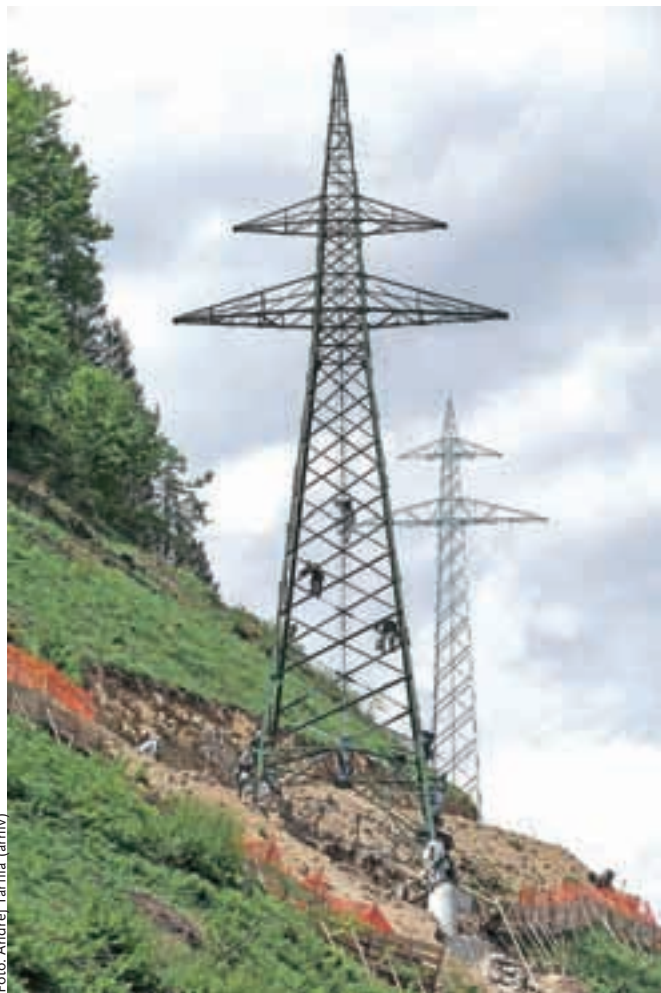
Gradnja daljnovoda na območju Železnikov
