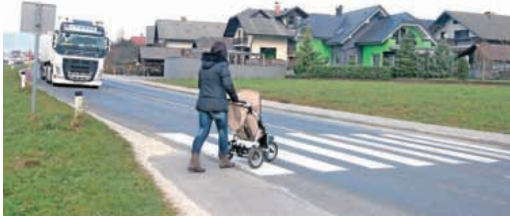
Nevaren cestni odsek na Godešiču / Foto: Tina Dokl
