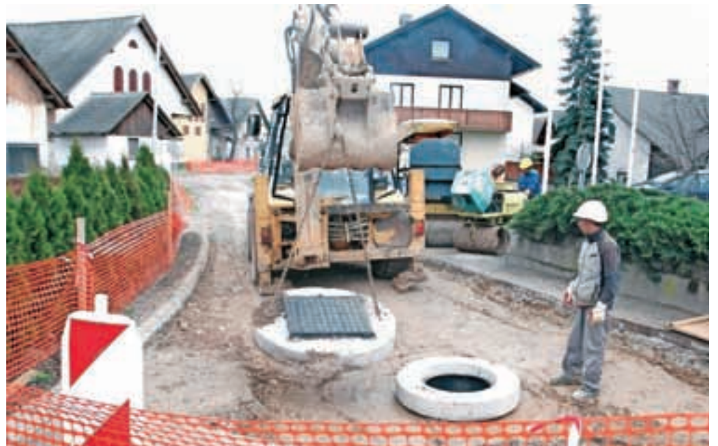
V kranjski občini so zgradili tri sklope novega kanalizacijskega omrežja v dolžini 34.945 metrov, od tega dobrih 23 tisoč metrov na območju Bitnje-Šutna-Žabnica (na fotografiji), kjer so začeli z deli oktobra 2013 in jih zaključili junija 2015. / Foto: arhiv Gorenjski Glas/Gorazd Kavčič
