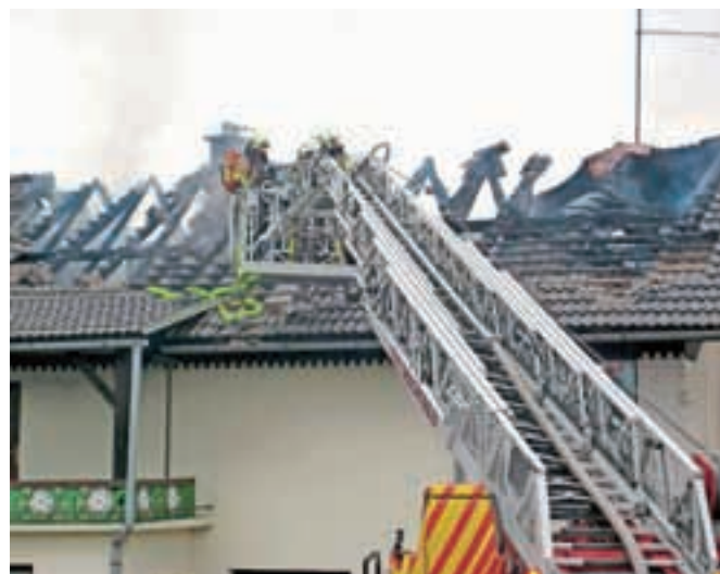
Pri gašenju požara so uporabili tudi gasilsko lestev.
