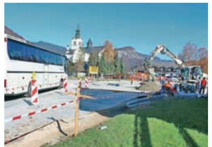
Gradnja novega krožišča v Bohinjski Bistrici je v polnem teku, predvidoma bo končana do konca novembra.
