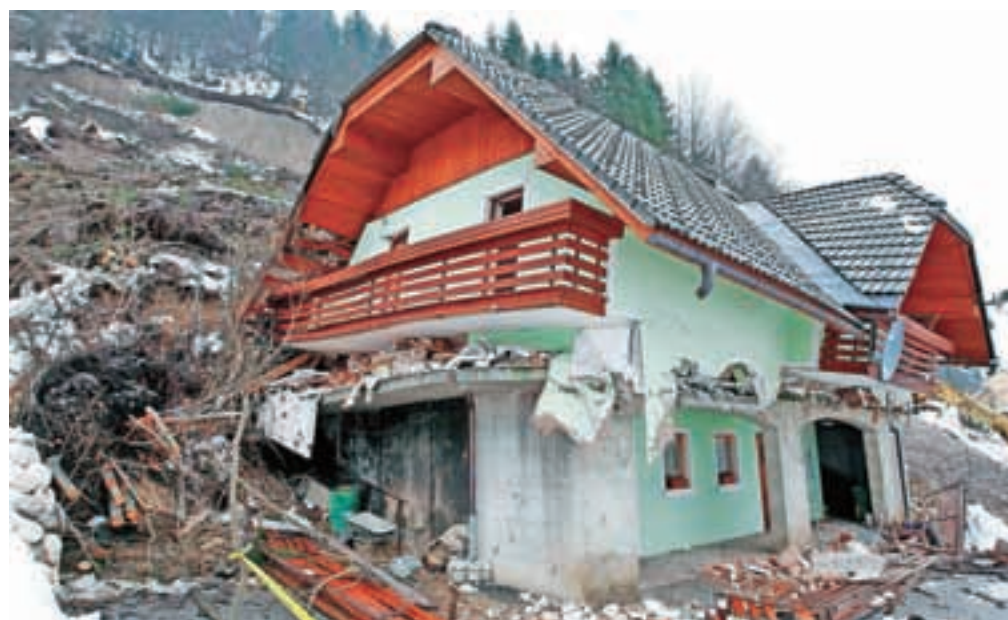
Kranjsko sodišče mora znova presoditi, ali sta Občina Bohinj in država odgovorni za sprožitev zemeljskega plazu v Srednji vasi v Bohinju, ki je 16. decembra 2008 prelomil stanovanjsko hišo z apartmajema družine Bremec. / Foto: Gorazd Kavčič (arhiv)
