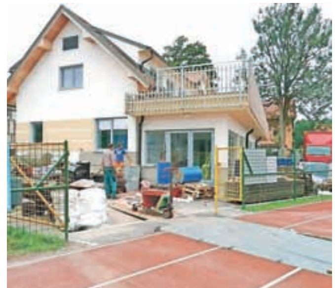
Poleg atletske površine je obnova zajela tudi dela v večnamenski stavbi ob stadionu.
