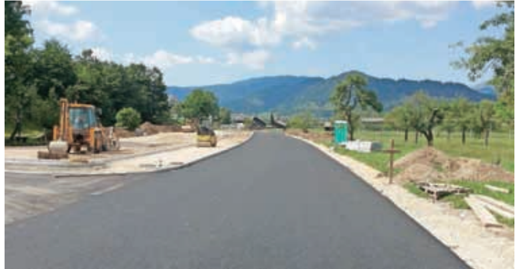
Na Bledu so končali obnovo Seliške ceste.
