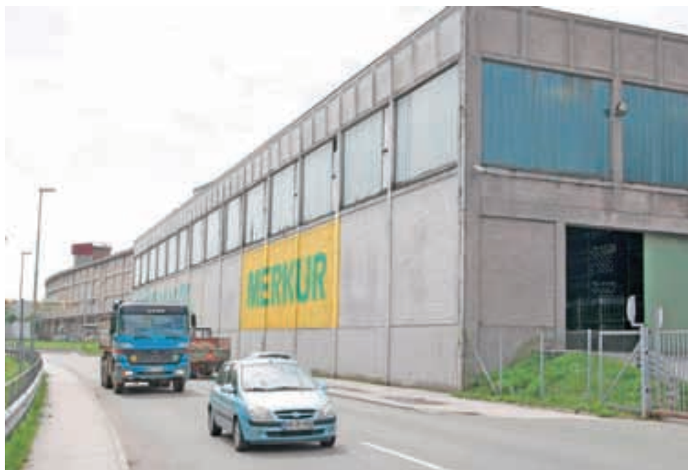
V stečajnem postopku nad starim Merkurjem so začeli prodajati prve nepremičnine. Kompleks ob železniški postaji v Kranju še ni med njimi.
