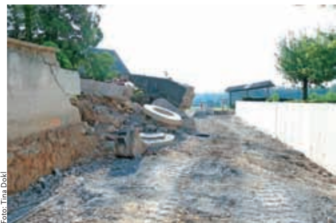
Menjajo oporni zid pokopališča pri cerkvi na Srednji Beli.
