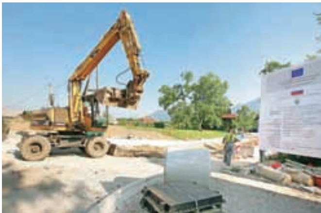
V občini Preddvor potekajo še zadnja dela pri ureditvi kanalizacije v petih naseljih. / Foto: Tina Dokl
