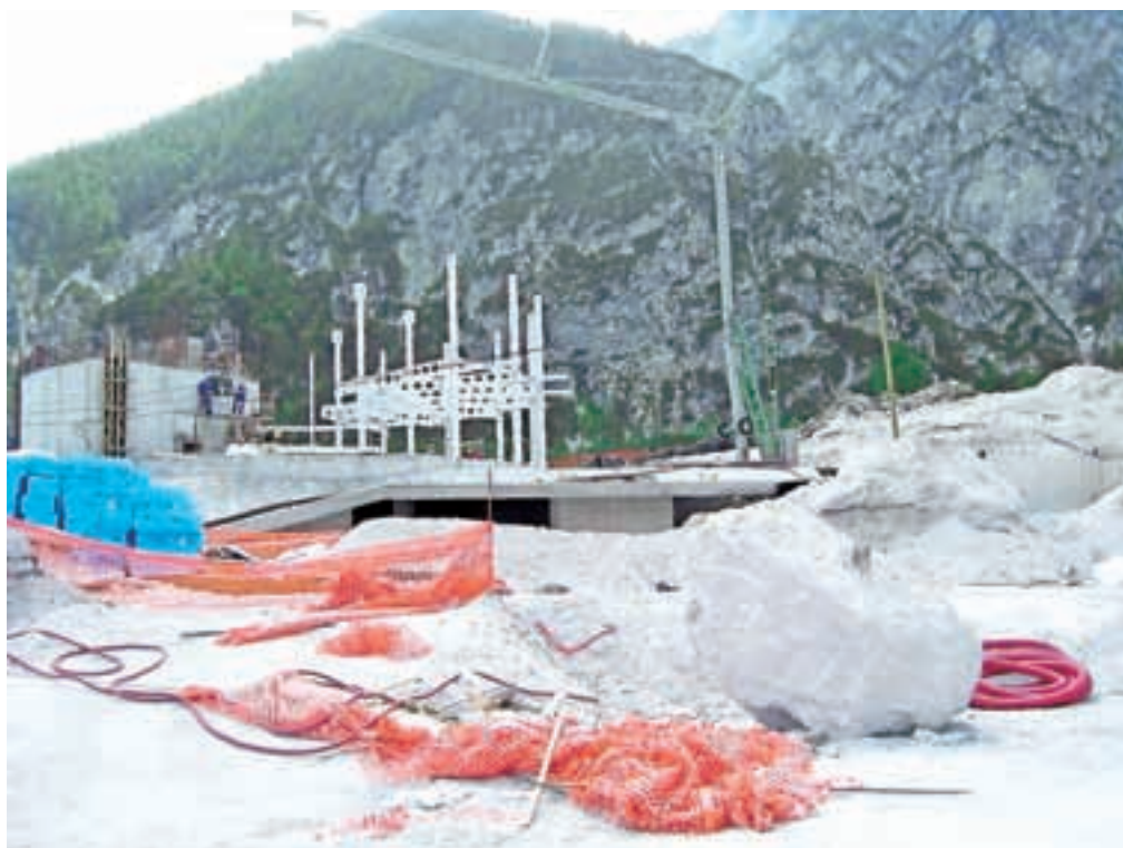
Osrednji objekt sega pet etaž v zemljo in bo dokončan do septembra.
