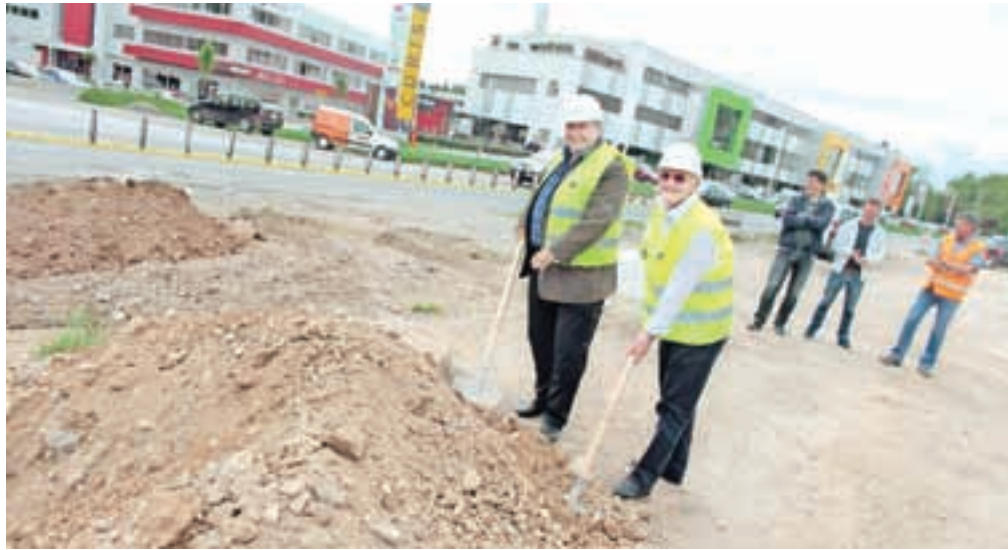
Župan Ciril Kozjek (desno) in direktor Gorenjske gradbene družbe Branko Žibera, tudi šenčurski občan, sta včeraj z veseljem poprijela za lopati. / Foto: Matic Zorman
