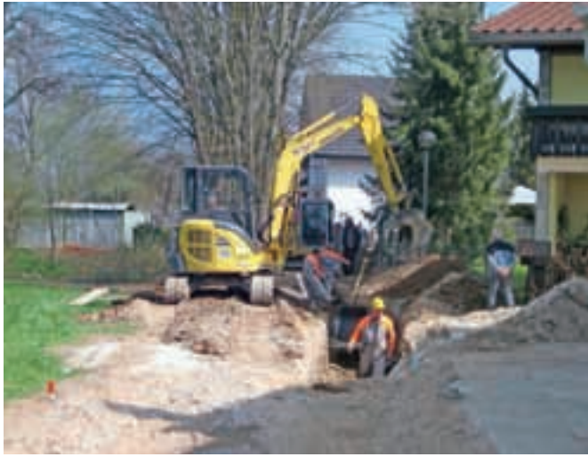
Povezovalni kanalizacijski vod naj bi zgradili do konca maja.
