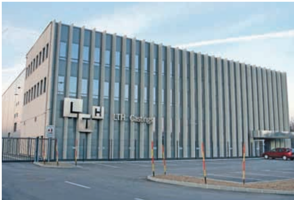
LTH Castings so orodjarno in razvoj preselili v industrijsko cono na Trati. / Foto: Tina Dokl
