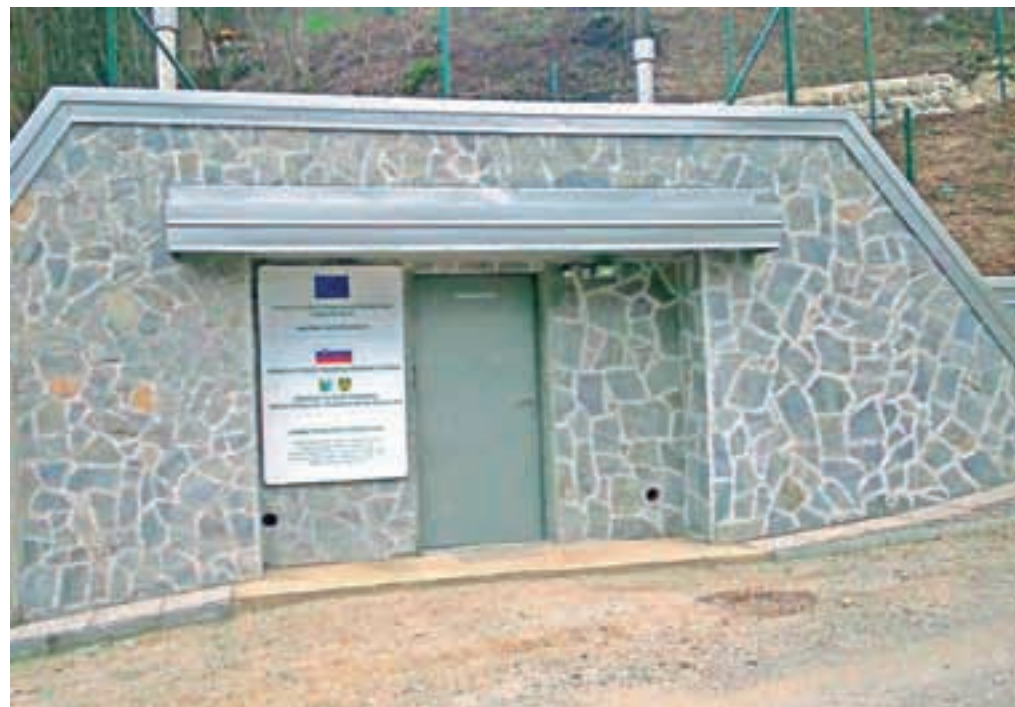
Novozgrajena prečrpalna postaja na Trebiji
