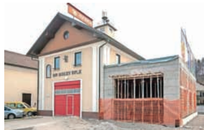
V prizidku bo garaža za gasilska vozila. / Foto: Luka Renar
