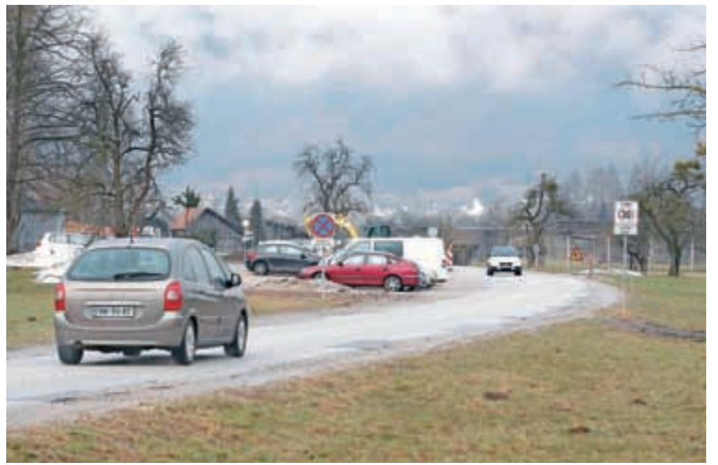
Z rekonstrukcijo Seliške ceste se bodo na Bledu kar sami lotili urejanja severne razbremenilne ceste. / Foto: Gorazd Kavčič
